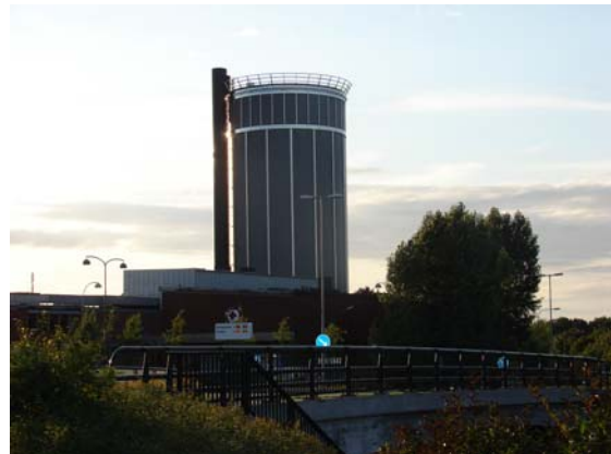
Här förvaras 11000m 3 vatten
